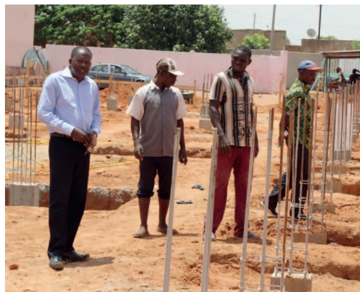
Ředitel burkinské IN pan Jean Kone (vlevo) u staveniště nové školní budovy.
